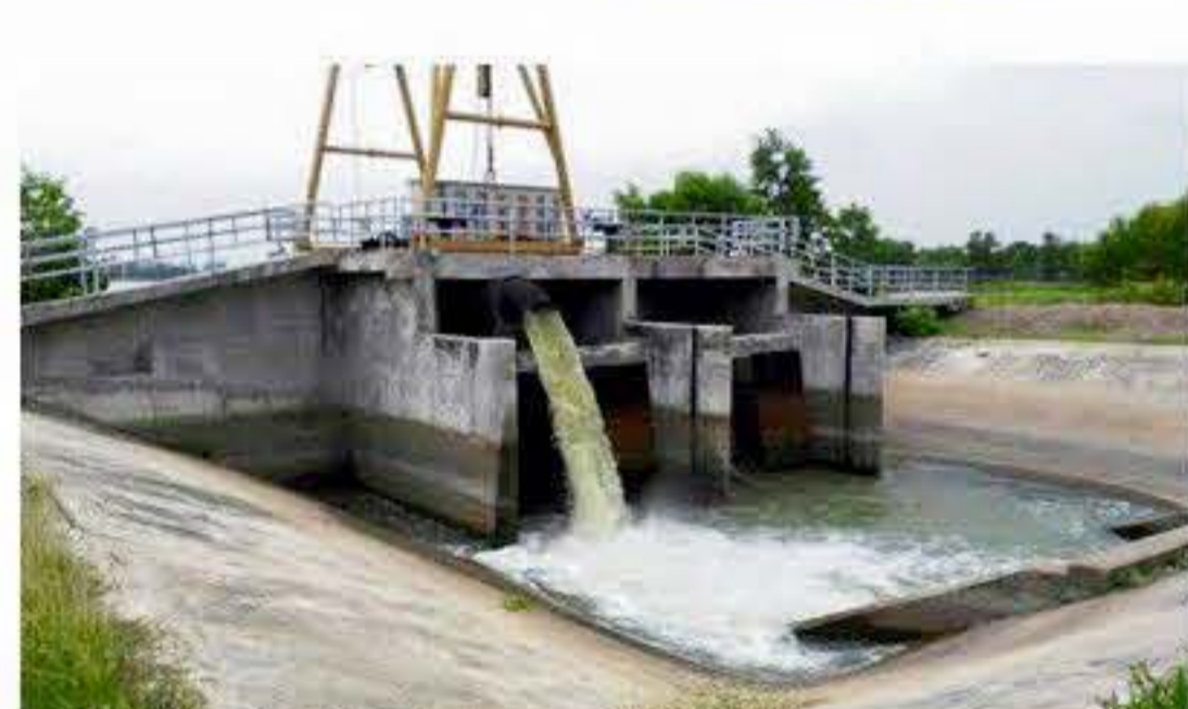
สถานีสูบน้ำด้านคลองห้า
